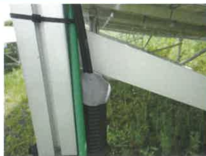
太陽光発電システム内各種配線貫通部のシール
