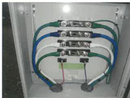
各種盤と配線の貫通部のシール
