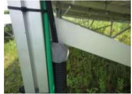
太陽光発電システム内各種配線貫通部のシール
