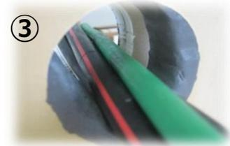
③ ボード内面まで耐火パテを隙間なく敷き詰めるように充填して下さい。
