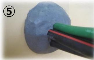
⑤ 開口部に対し耐火パテの被り(10mm以上)を確保し、おわん型(内面から50mm以上)に盛り上げて下さい。反対側も同様に施工を行って下さい。
