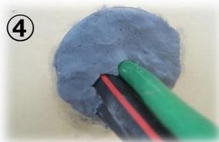
④ ケーブル周囲も耐火パテを隙間なく充填して下さい。
